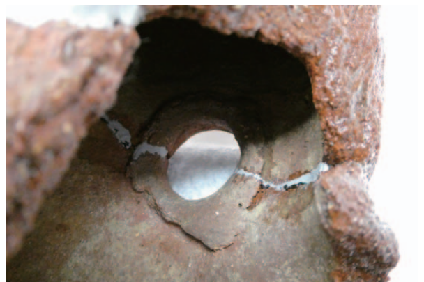
⑫補填 内側の接合部や亀裂への充填
