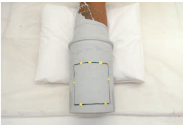
⑲接合作業用の窓を埋める
